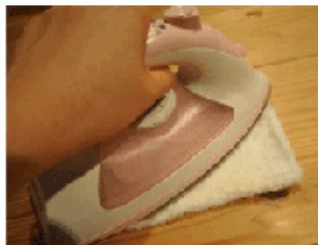
傷の上に濡れタオルを置きアイロンを当てる。この作業を、凹み傷がある程度元に戻るまで、様子を見ながら数回繰り返します。
