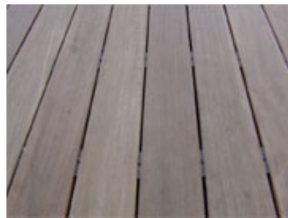
イベデッキ 経年変化 (上)施工時の状態 (下)施工数年後
