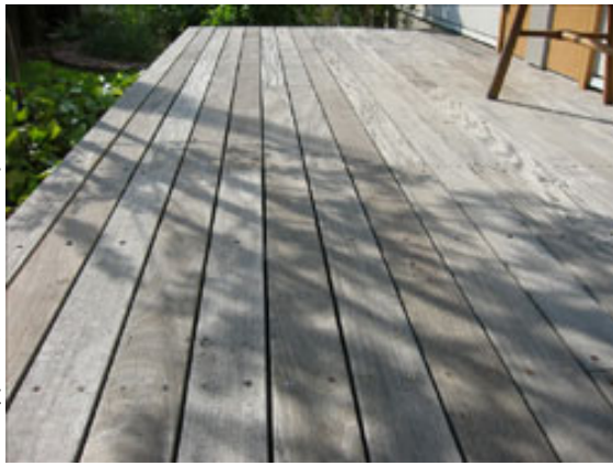
屋外で使用した例 イベデッキ イベのように硬く 耐久性が高い木材は風化のスピードが遅い。
